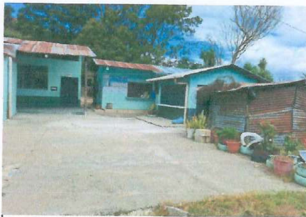
Foto 2: Cubierta de lámina.
