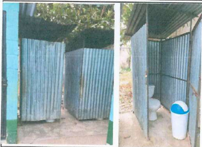
Foto 1: Remozamiento de 2 servicios sanitarios y sus accesorios.
